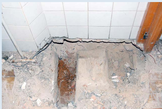
Slika 15: Pred posegi je treba oceniti tudi stanje stropnikov.
