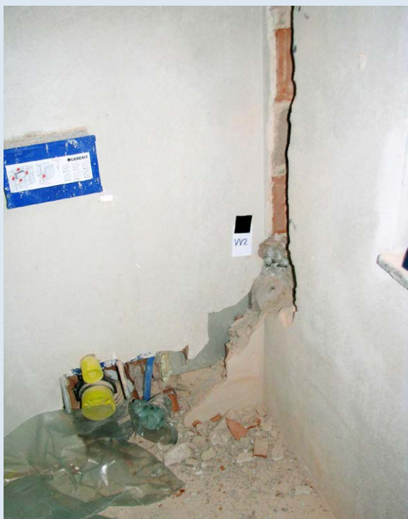
Slika 3: Prekinitev navpične AB zidne vezi z utorom.
