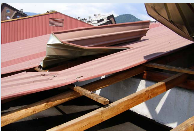
Slika 29: Neustrezno pritrdjevanje letev z gladkimi žičniki.
