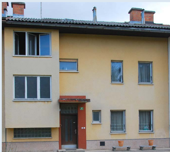
Slika 11: Sprednja fasada je oslABLJENA s številnimi odprtinami.
