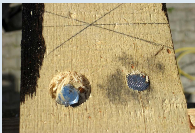
Slika 30: Za povezovanje se priporoča uporaba vijakov.
