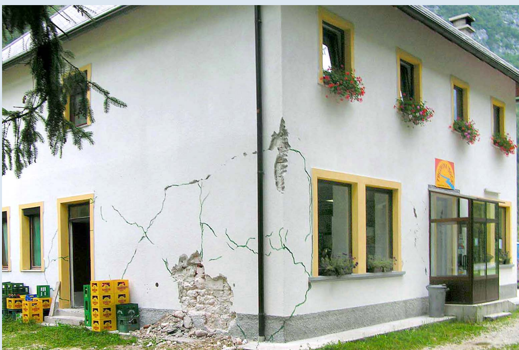
Slika 26: Po potresu poškodovano nadstropje kamnite hiše je bilo na novo sezidano s sodobnimi opečnimi votlaki, kamnito zidovje v pritličju pa ni bilo ustrezno utrjeno. Med ponovnim potresom je hiša utrpela hude poškodbe le v pritličju.
