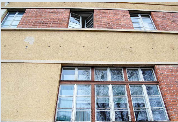
Slika 14: Pri obnovi fasad ni dovoljeno prekriti odprtlin, namenjenih zračenju stropnikov.
