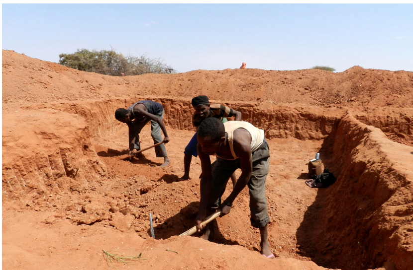
Gradnja vodnjaka v Somaliji (IRD Global Zavod)
