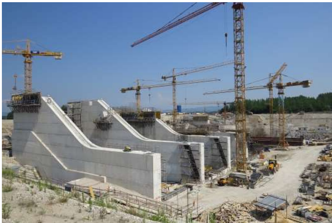
Slika 4: Strokovna ekskurzija – Izgradnja jezovne zgradbe HE Brežice», 2015 (2)
